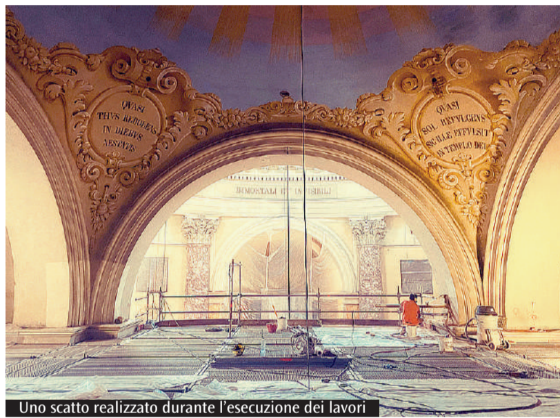
Uno scatto realizzato durante l'esecuzione dei lavori
