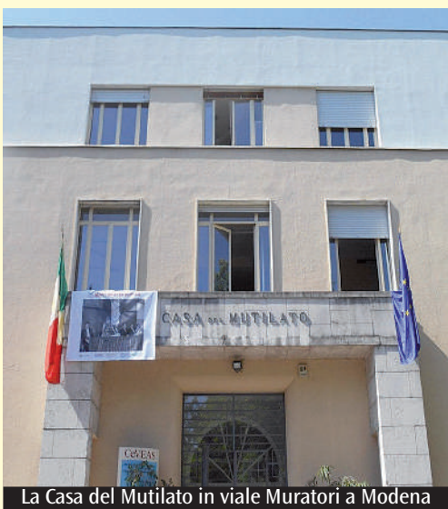
La Casa del Mutilato in viale Muratori a Modena
