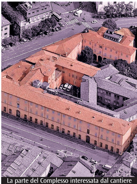
La parte del Complesso interessata dal cantiere
