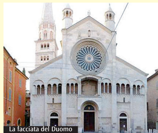
La facciata del Duomo
