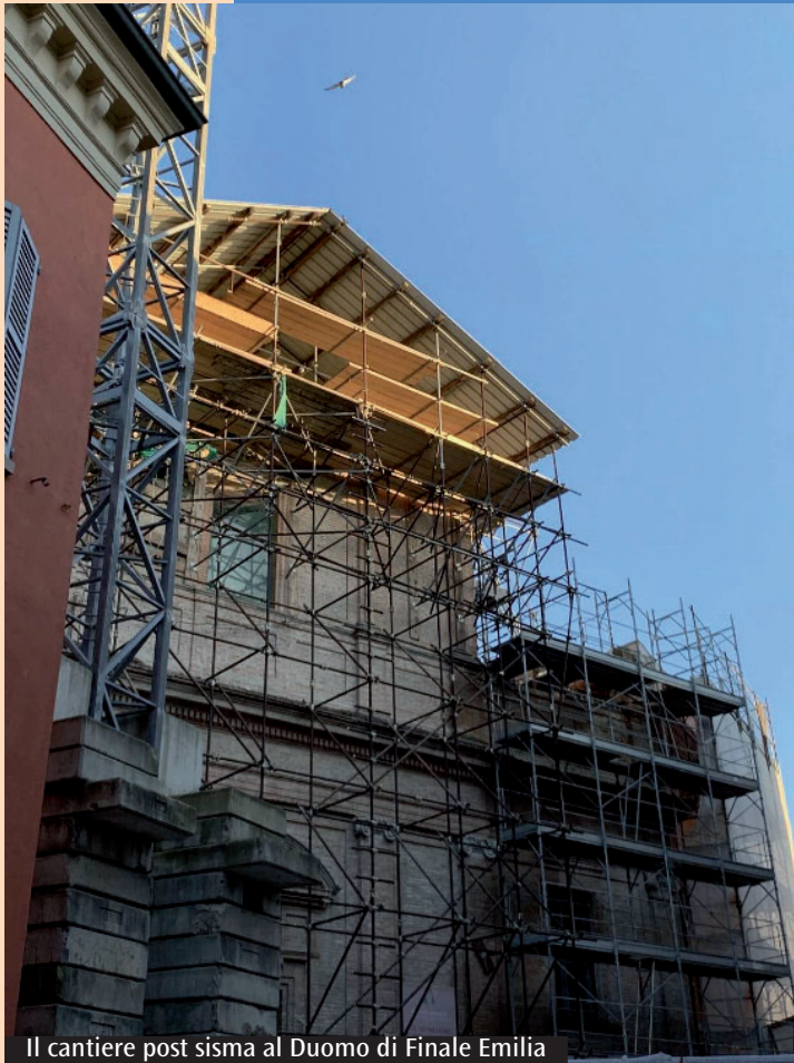
Il cantiere post sisma al Duomo di Finale Emilia
