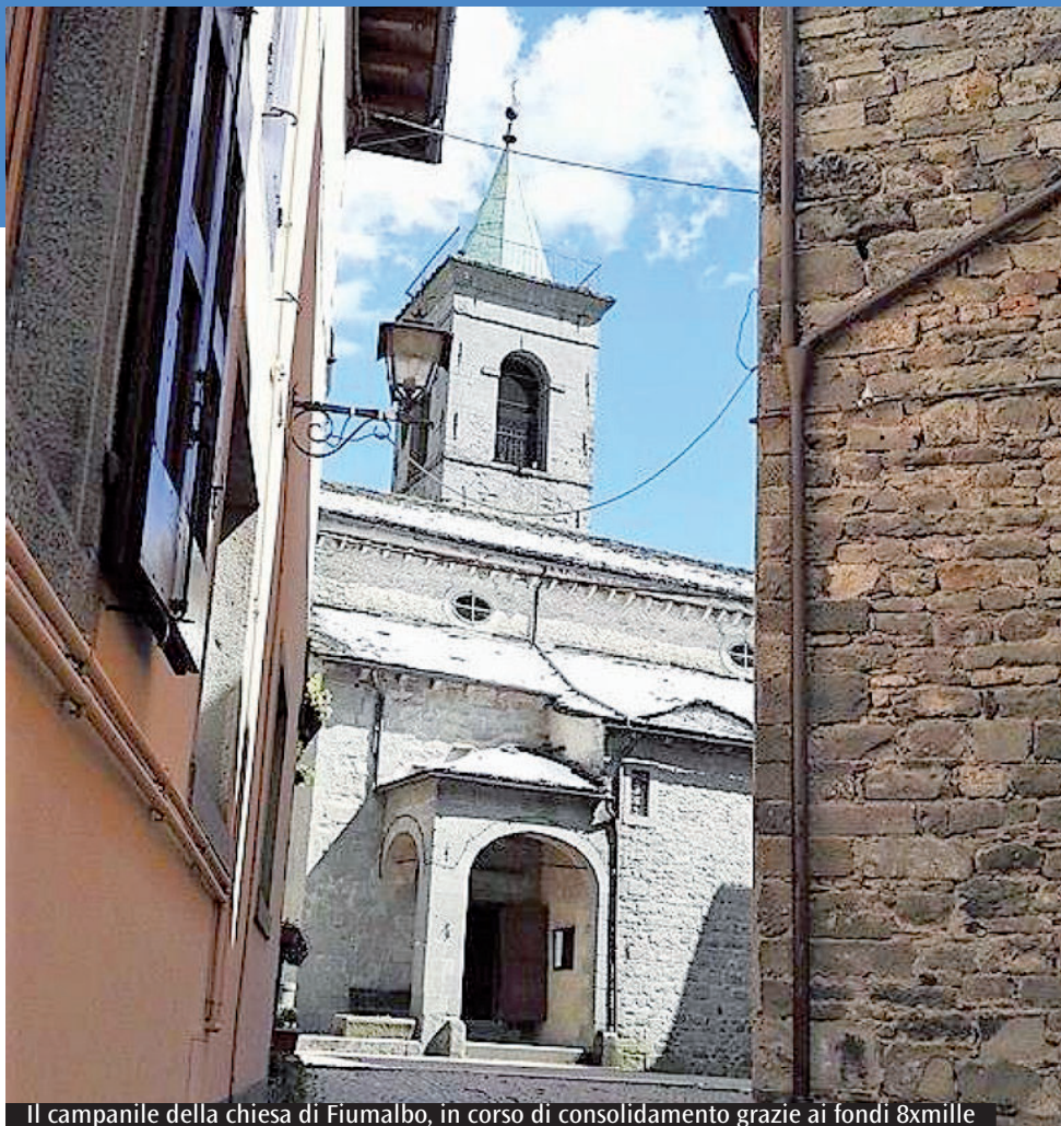
Il campanile della chiesa di Fiumalbo, in corso di consolidamento grazie ai fondi 8xmille
