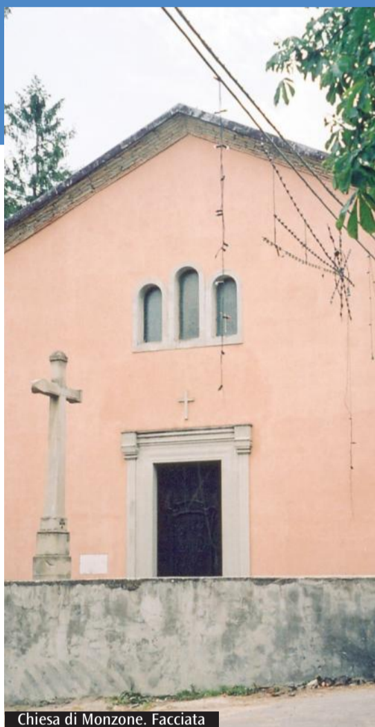
Chiesa di Monzone. Facciata
